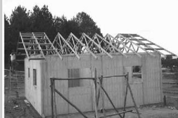
Structure en fermette
